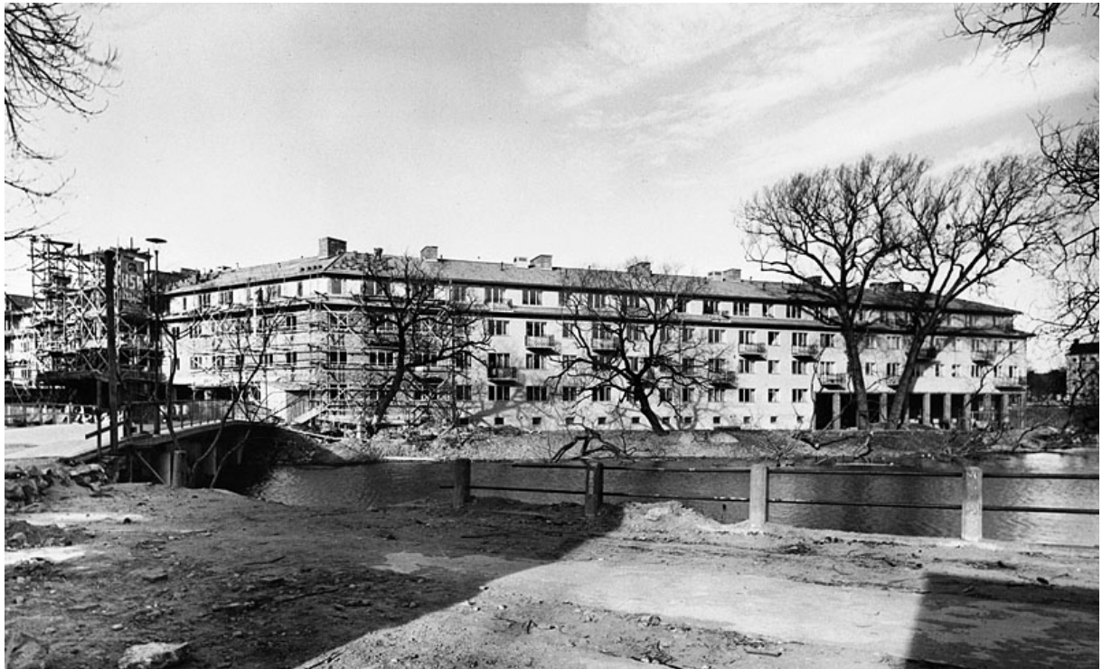
Reimersholmsbron under konstruktion
